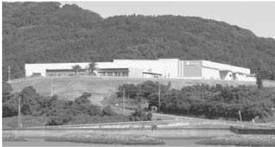
昨年9月に竣工したF1松浦工場。フッ素樹脂製品などを扱い稼働率はすでに8割に達している
